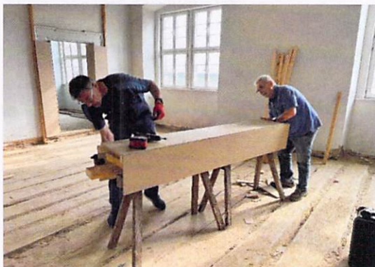
Arbeiten an Schutzschalungen der Innentüren
