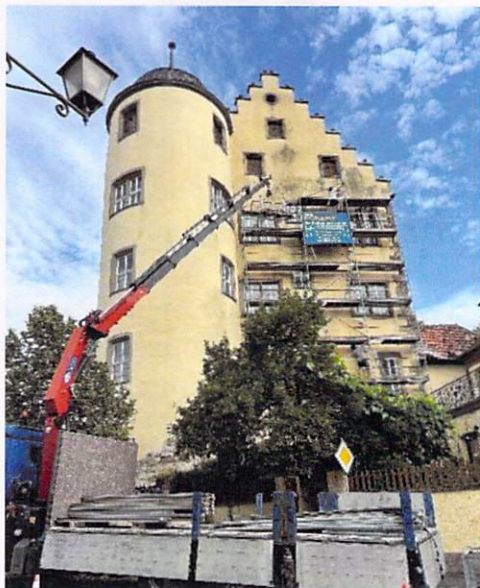
Oben: Abbau des Gerüsts, Südseite
